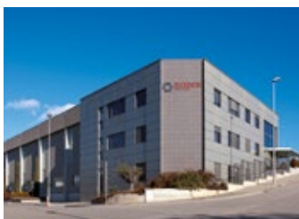
● Výrobní závod Torelló (Španělsko)
