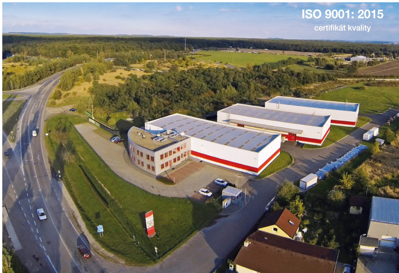
Logistický areál ELEKTRODESIGN ventilátory s.r.o. ve Staré Boleslavi v prostoru mezi dálnicí E65/D10 a vnitřní komunikací do Staré Boleslavi.
